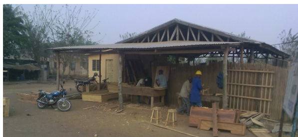
Les travaux se sont réalisés à l'atelier Création BETSALEL.
